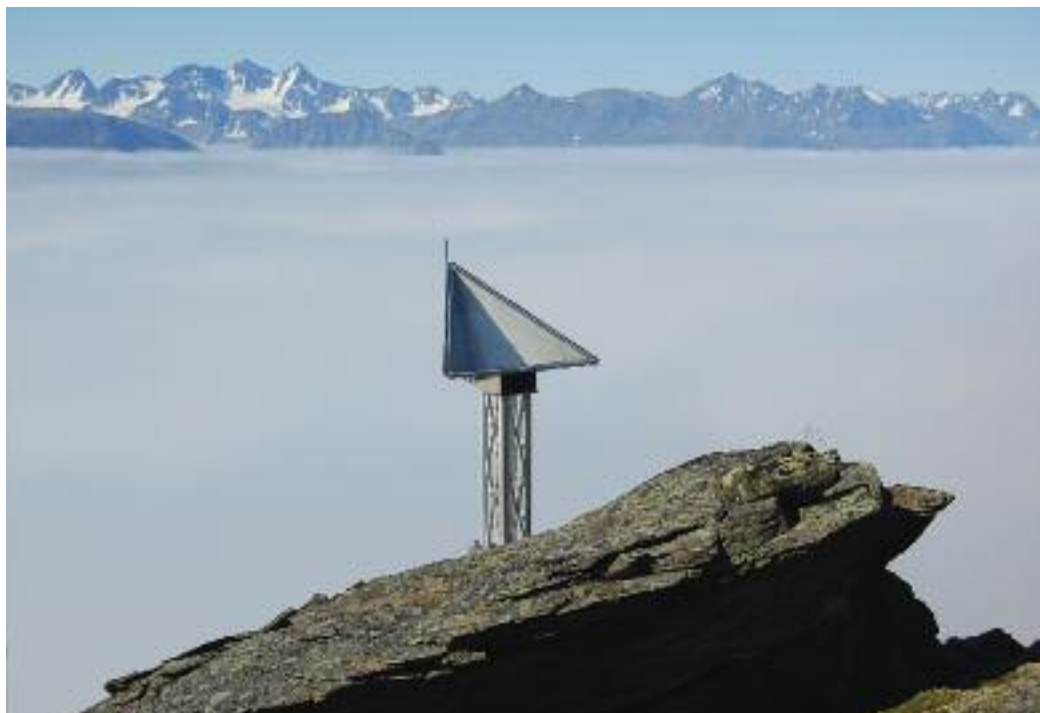
Figur 3.5. Fastmontert reflektor (0,8 m) ved Nordnesfjellet i Troms. Reflektoren er montert på en mast direkte boret ned i fjellet og er en naturlig spredde av signal. For å unngå ansamling av snø er reflektoren dekket av pleksiglass. (Harald Øverli Eriksen)
